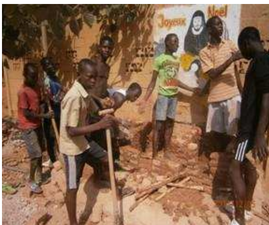
Bau der Krippe
